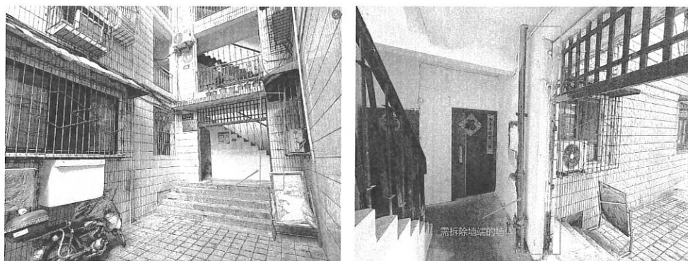
图 5-2 需拆除墙端墙体外观现状
