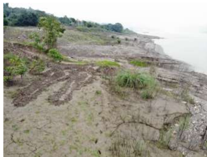
照片6-2 长江岸坡1#地块段近貌
