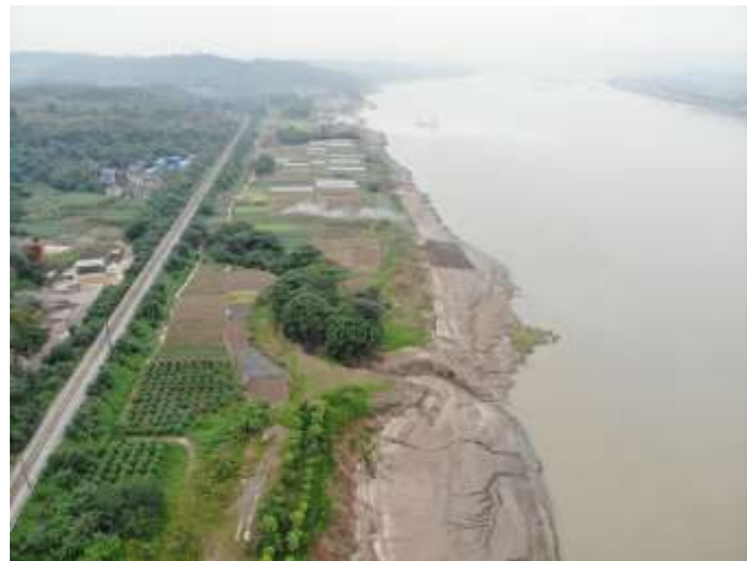
照片6-1 长江岸坡1#地块段全貌
