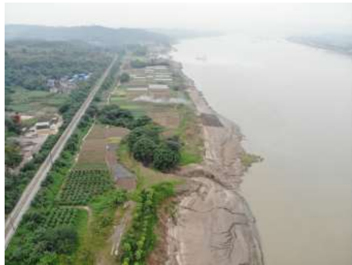
照片3-1 长江岸坡1#地块段全貌
