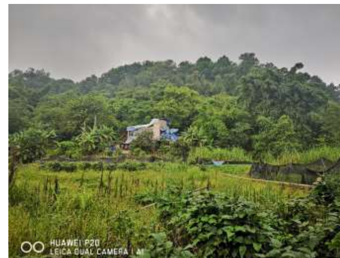
照片 6-1 朱家湾滑坡全貌
