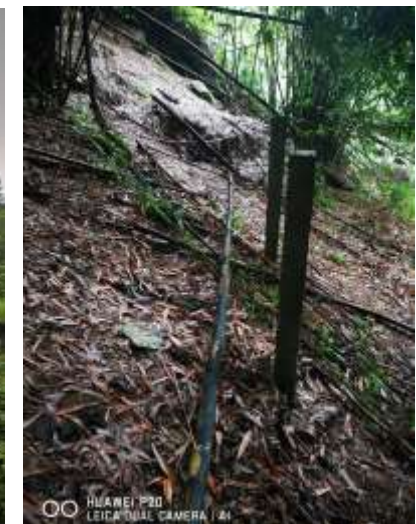
照片 6-2 监测桩无倾斜迹象
