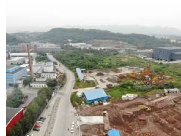
照片 4-3 4#地块建成区、在建区
