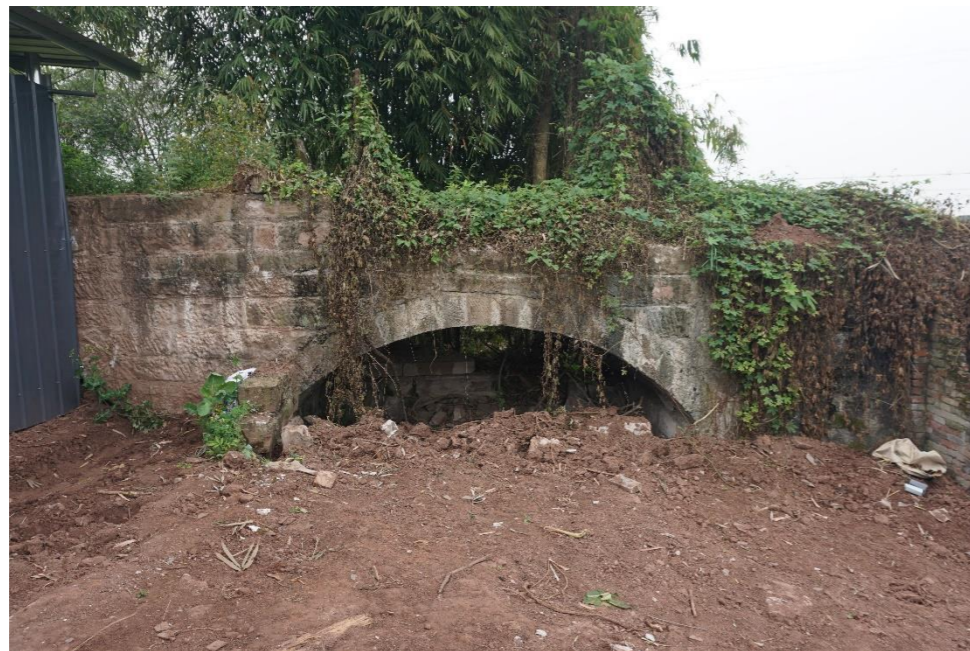
照片 28 刘家湾渡槽
