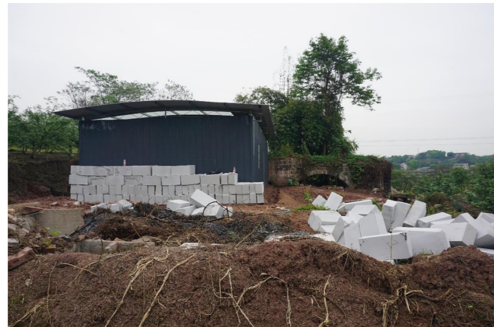
照片 29 刘家湾渡槽远景
