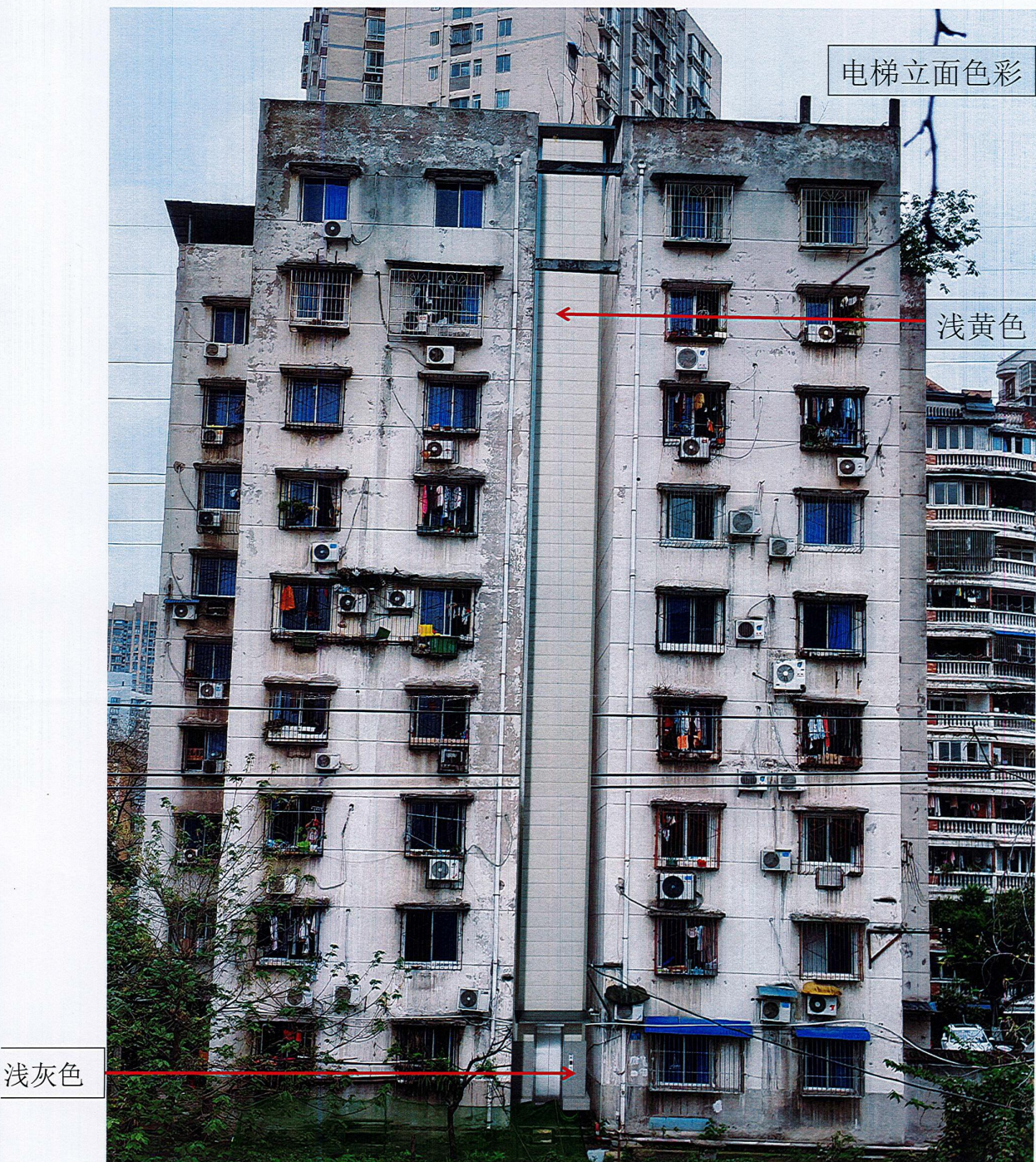
电梯层站：9 层 8 站
