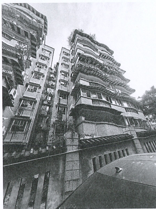
图 3.1.2 房屋背面现状照片
